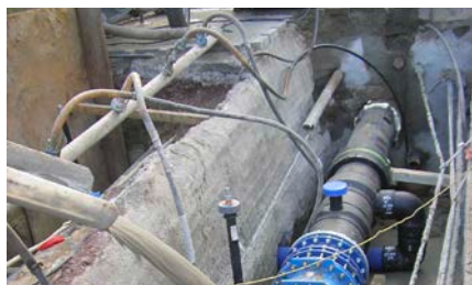
Verfüllung von Baugruben
