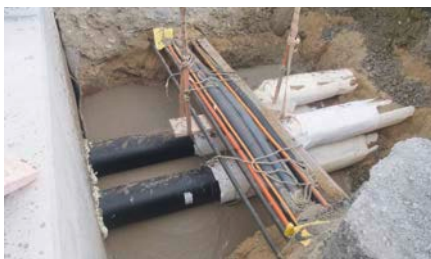
Verfüllung von Fernwärmeleitungen
