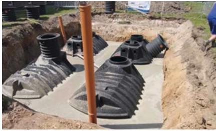
Verfüllung von Kleinkläranlagen
