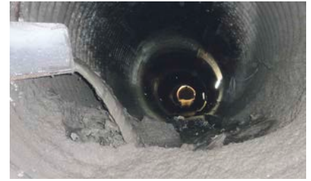
Verfüllung von Schächten
