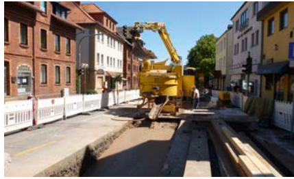
Verfüllung von Rohrleitungen
