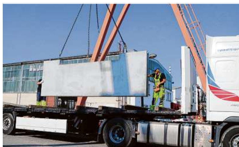
Abtransport: Eine Sockelwand wird verladen. Sie muss auf der Baustelle nur noch aufgestellt und verankert werden.
