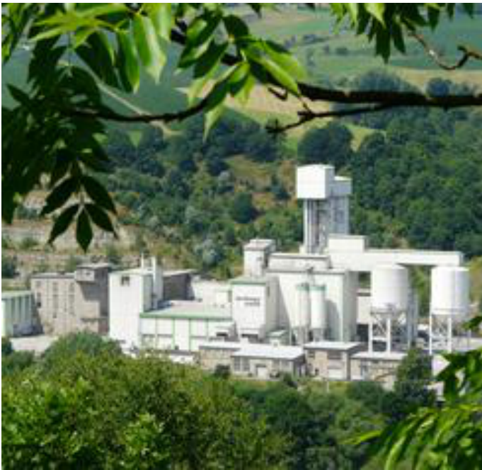
Zementwerk in Dornburg-Camburg
