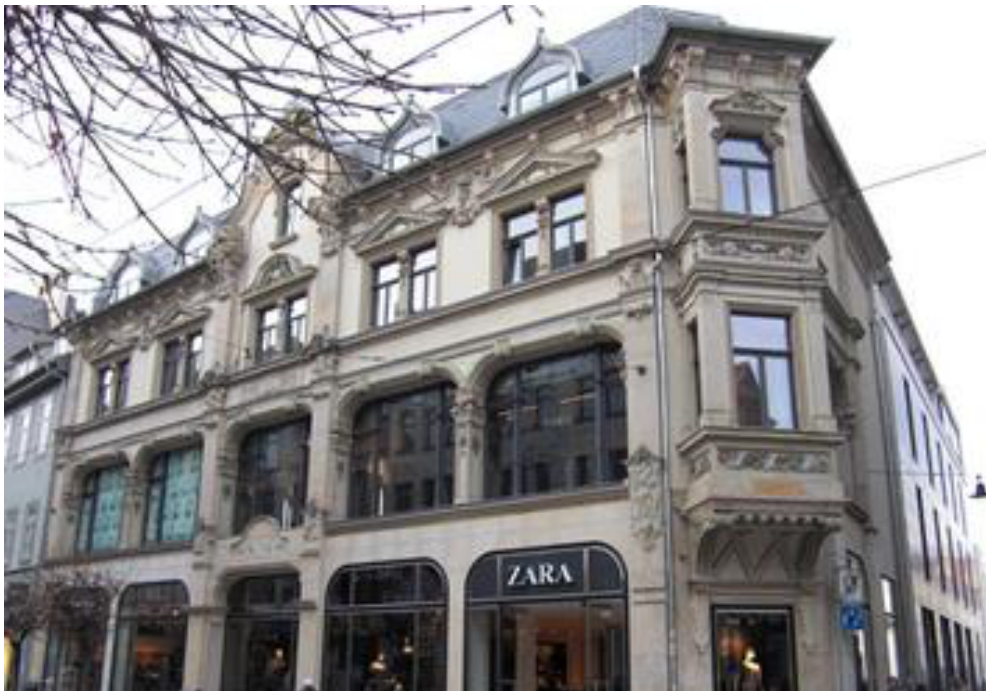
thomas transportbeton: Wohn- und Geschäftshaus Erfurt Zentrum
