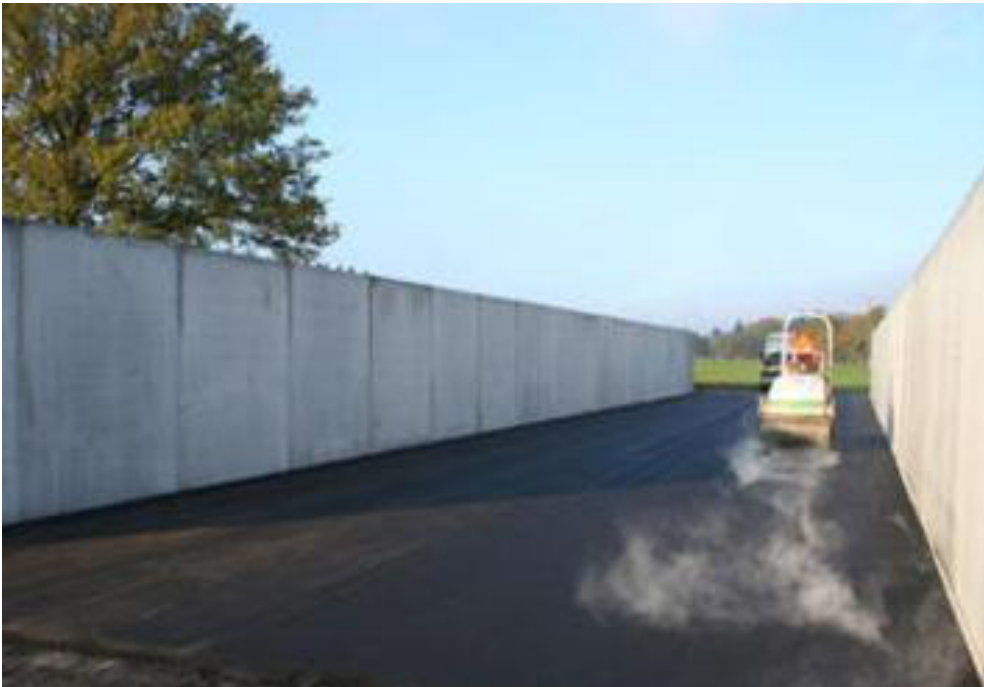
thomas naturstein-asphalt: Landwirtschaftliche Fahrsiloanlage - Asphalt
