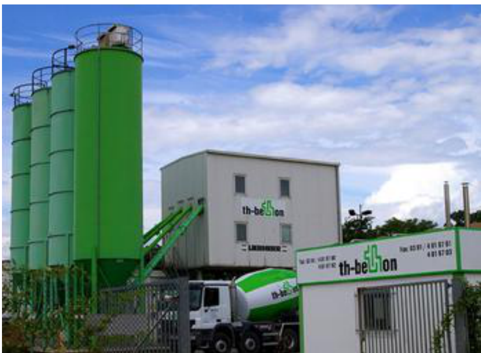
Zakład betonu towarowego w naszej siedzibie w Magdeburgu (Saksonia-Anhalt)
