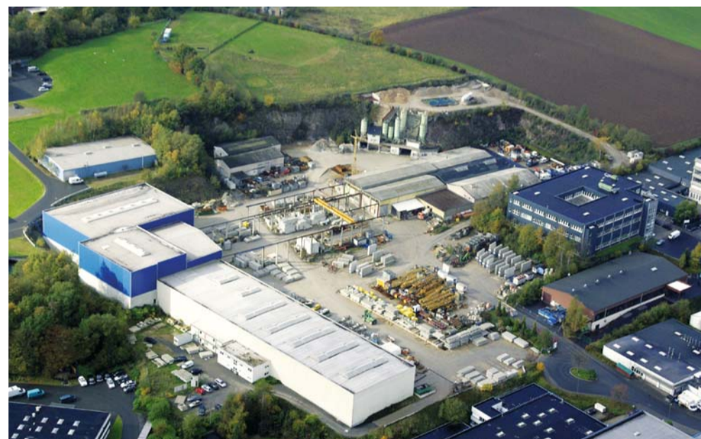
Betonbauteilwerk von betoform in Remscheid
