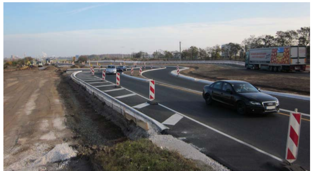
Während der Baumaßnahme muss der der Verkehr ins Industriegebiet erhalten bleiben.
