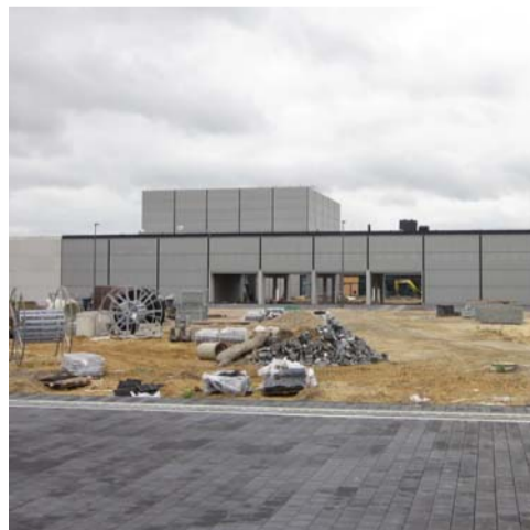
Feuerwache auf dem Gelände Flughafen BBI (Stand 14.07.11)
