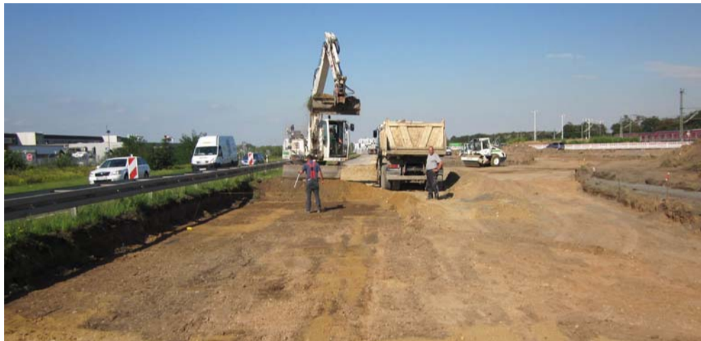
Die neue Hauptzufahrt in das Mönchhofareal wird als Turbokreisel hergestellt.
