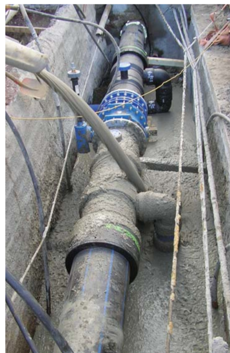
Verfüllung im beengten, verdichtungsfrei zu verfüllenden Kanalgraben in Magdeburg (Lieferwerk th-beton Magdeburg)
