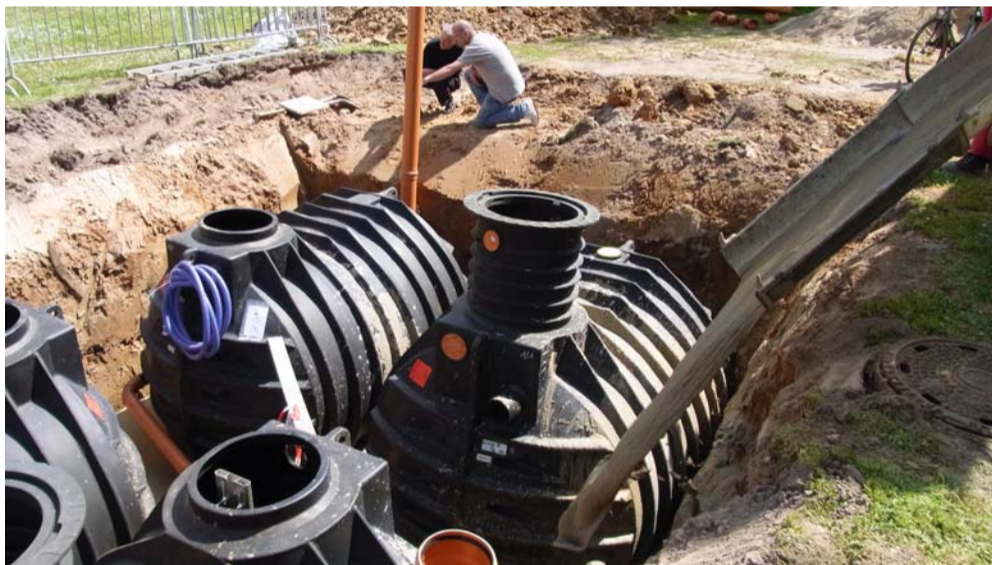
Verfüllung von Kleinkläranlagen Modulen mit Bodenmörtel aus carbofill® S (Lieferwerk th-beton Podewitz)
